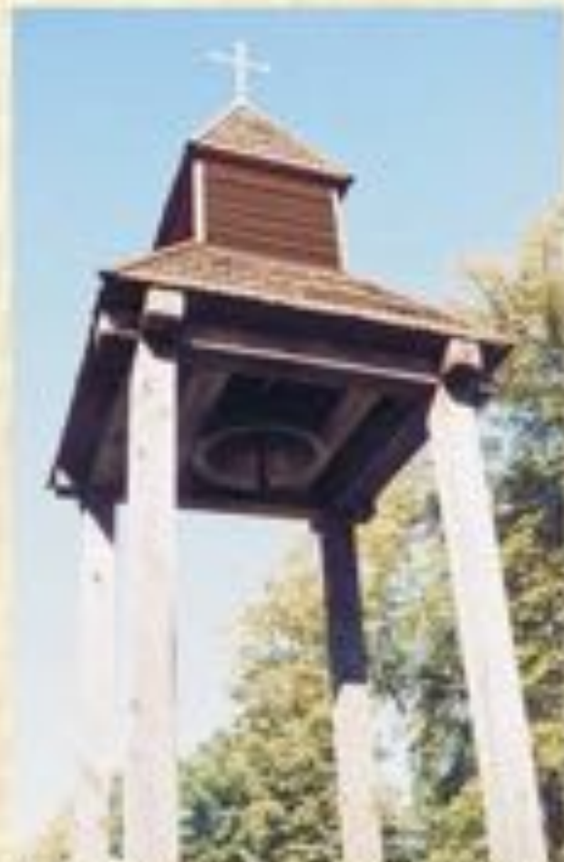
2002 m. pirmosios Tauragėje bažnyčios vietoje pastatyta simbolinė varpinė (arch. A.Liočas).
